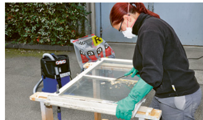
2 Mesures de protection lors du retrait du mastic de vitrier contenant de l'amiante
