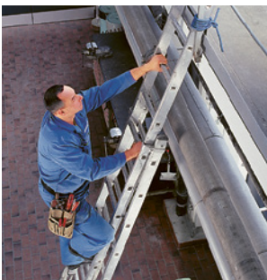
1 Échelle sécurisée contre tout risque de glissement
