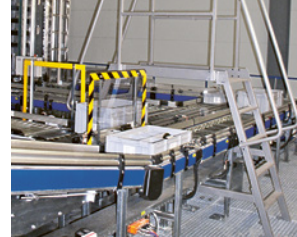
3 Passerelle au-dessus d'un transporteur à rouleaux
