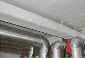
Kabelkanal aus Asbestzement
