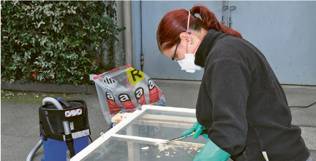
Entfernen von asbesthaltigem Fensterkitt mit Stechbeitel oder Spachtel. **Diese Arbeit muss im Freien ausgeführt werden!**
