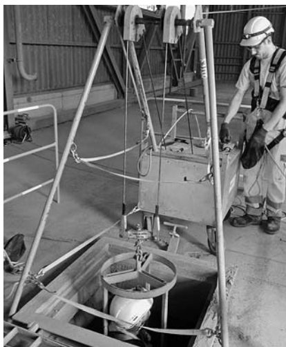
11 Descente dans le silo au moyen d'un treuil de silo et d'une nacelle. Ces équipements doivent être conformes aux normes européennes.
