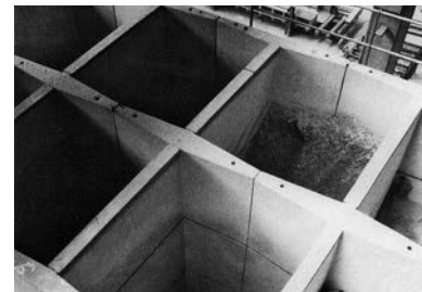
4 Silos sans échelle fixe (meilleure solution)
