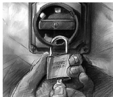
8 Interrupteur de sécurité en position 0 et verrouillé avec un cadenas individuel
