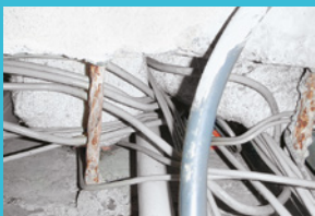
Due esempi di sbarramenti antincendio con cuscini di amianto
