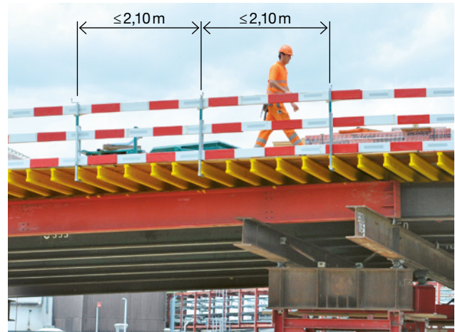
1 Seitenschutz mit rot-weissen Absperrlatten: maximaler Pfostenabstand 2,10m
