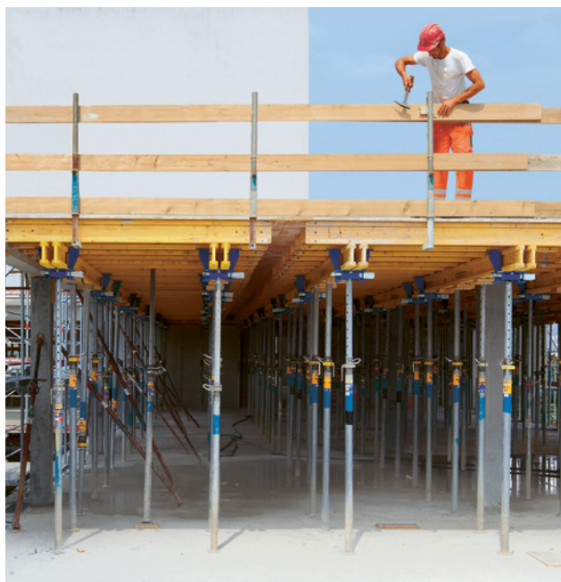
3 Seitenschutz mit Schutzgeländerzwingen
