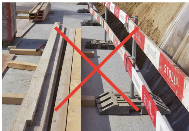
6 Gummisockel für den Seitenschutz an Deckenkanten sind verboten, weil der Seitenschutz leicht kippen kann.
