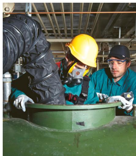
8 Ventilatore di aspirazione installato per lavorare in una cisterna.
