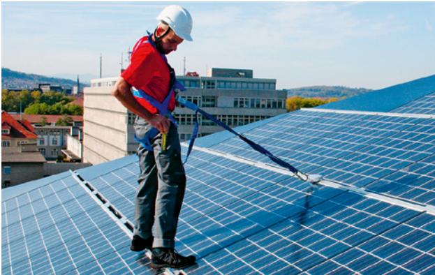
13 Système d'ancrage intégré dans l'installation solaire
