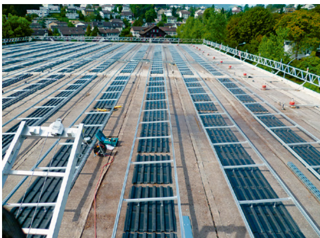
2 Montage d'une installation solaire avec garde-corps périphérique temporaire sur le bord du toit
