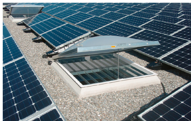
1 Puits de lumière avec grillage contre la rupture
