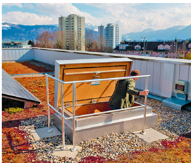
11 Escalier d'accès interne au bâtiment
