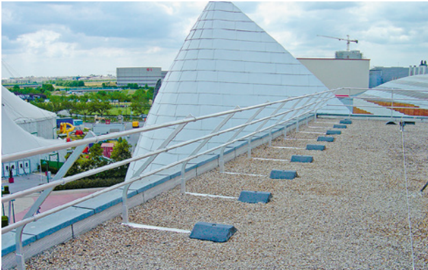
7 Garde-corps sans fixation à la toiture, pour une utilisation temporaire ou permanente
