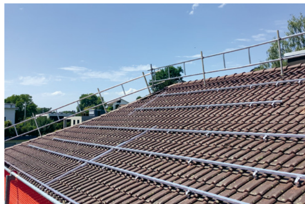
3 Le garde-corps périphérique installé sur le faîte empêche les chutes sur le côté du toit non concerné par les travaux.
