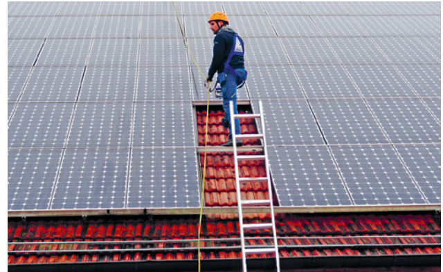
15 Corde lancée par-dessus la toiture, assurée par un antichute mobile
