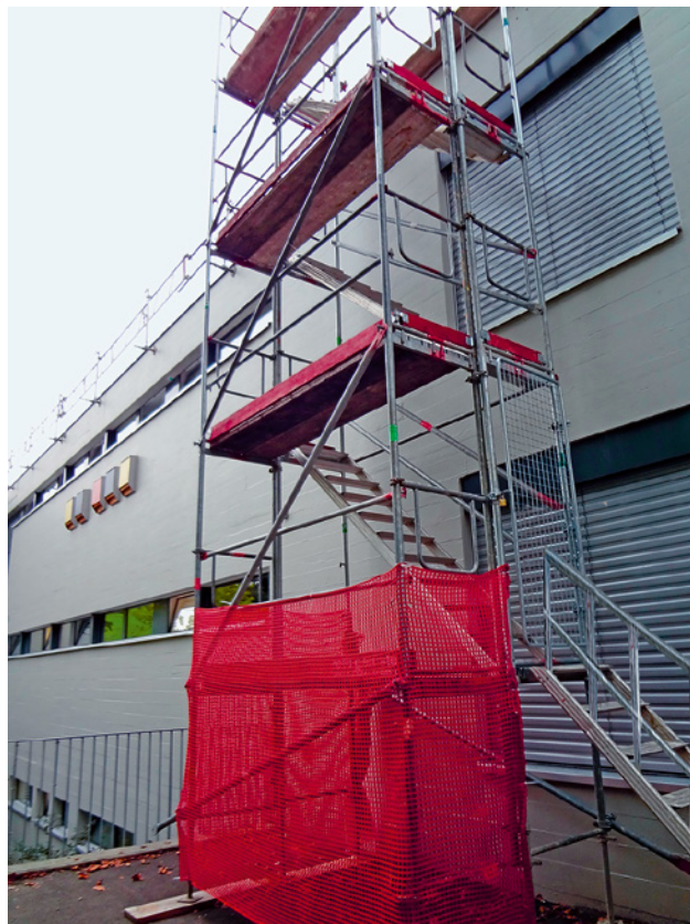
4 Accès sûr par une tour d'escalier
