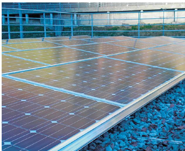
5 Installation solaire sur un toit plat avec garde-corps permanent sur le pourtour
