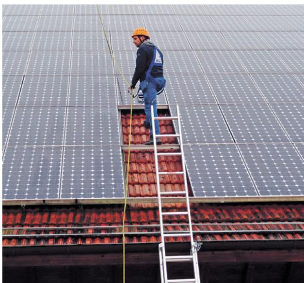
15 Corde lancée par-dessus la toiture, assurée par un antichute mobile
