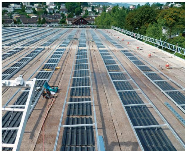
2 Montage d'une installation solaire avec garde-corps périphérique temporaire sur le bord du toit
