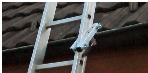
16 Accès sûr au toit pour les travaux de courte durée; échelle assurée sur le bord du toit
