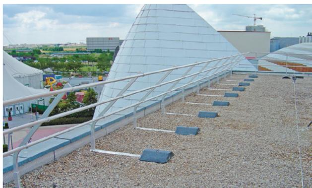
7 Garde-corps sans fixation à la toiture, pour une utilisation temporaire ou permanente
