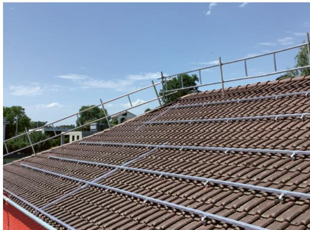
3 Le garde-corps périphérique installé sur le faîte empêche les chutes sur le côté du toit non concerné par les travaux.
