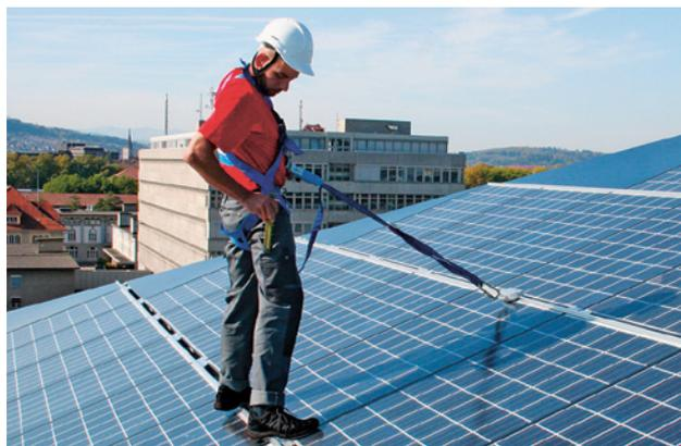
13 Système d'ancrage intégré dans l'installation solaire
