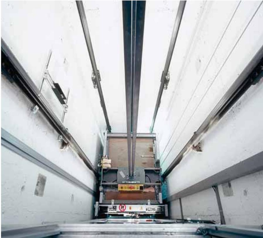
01 // Blick aufs Dach einer Liftkabine: Hier darf nur gearbeitet werden, wenn die Kabine gegen jede Art von unkontrollierter Bewegung (wie einen Absturz) gesichert ist. // Bild: Suva
