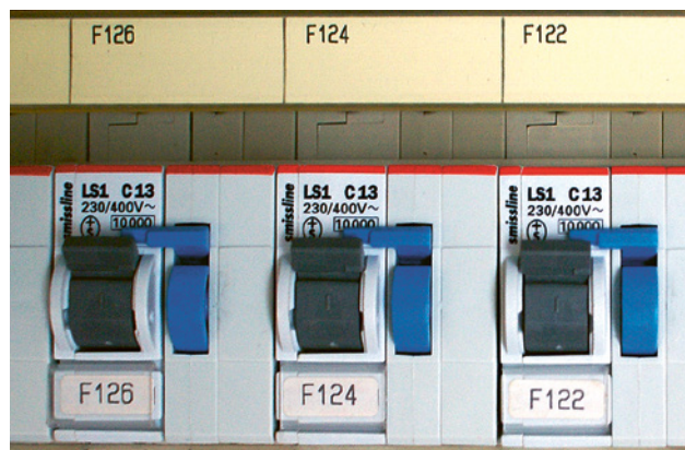
11 Interruttore magnetotermico
