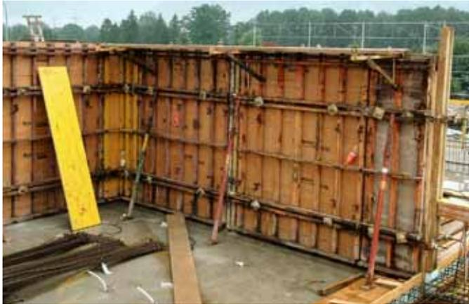
01 // Falsch: Von diesem Konsolgerüst stürzten die beiden Arbeiter auf den Betonboden. Auch der Seitenschutz fehlte. // Bild: Suva
