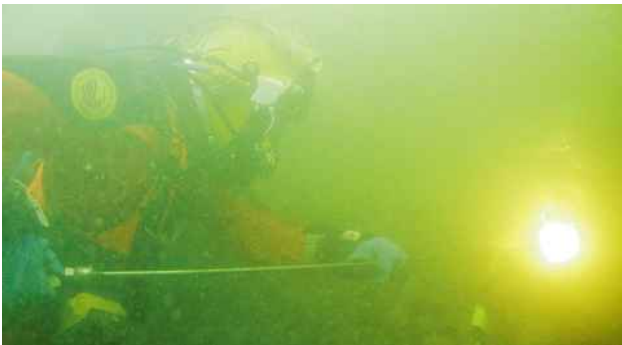
Saldatura subacquea. Foto: F. Hattan, Hergiswil
