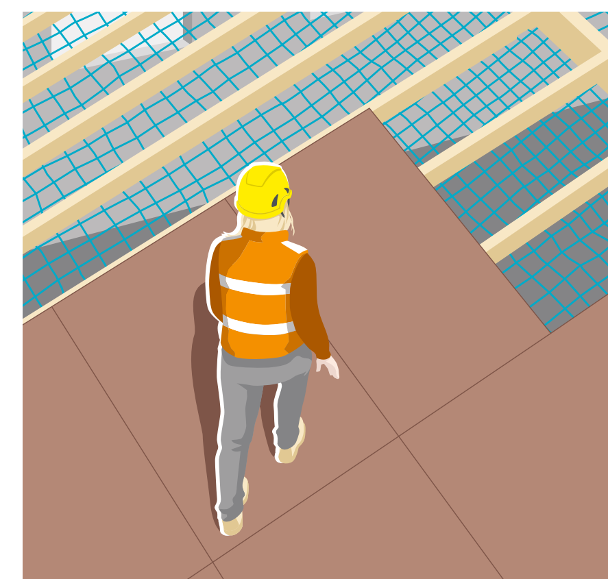
Regel 3: Wir sichern uns gegen Absturz ins Gebäudeinnere ab 2 m Absturzhöhe.
