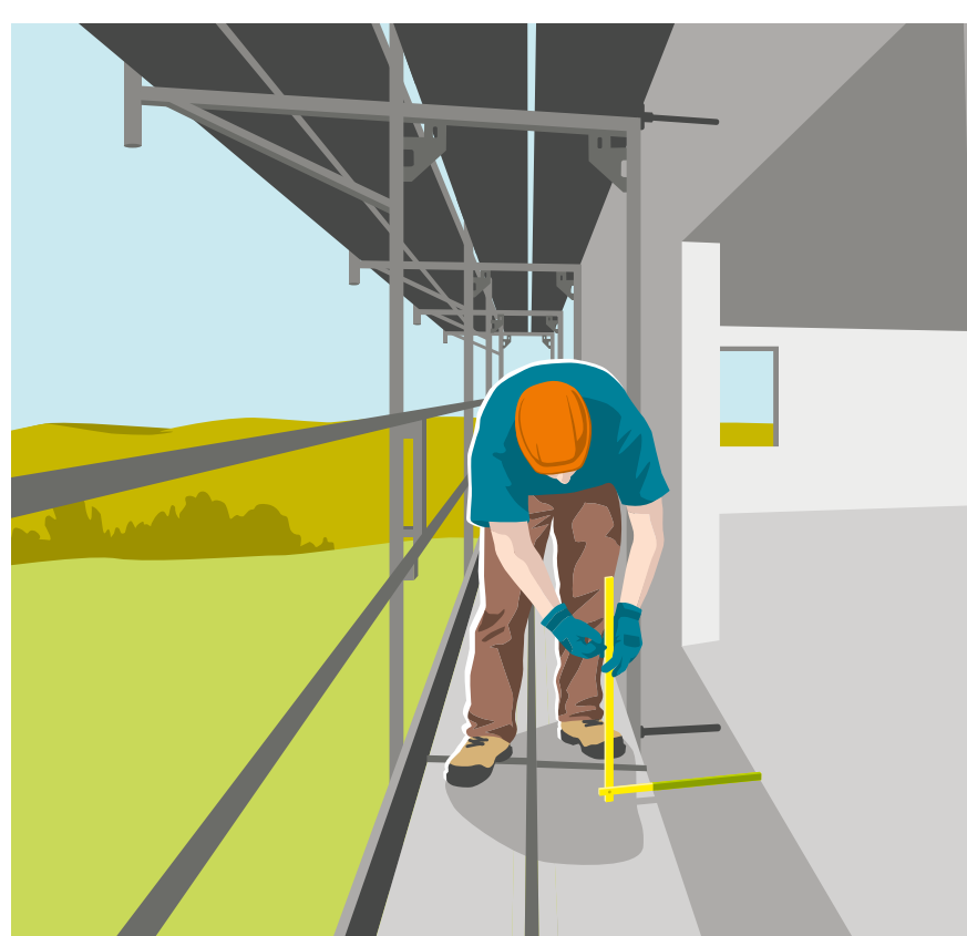
Regel 7: Wir kontrollieren die Gerüste vor dem Benützen.
