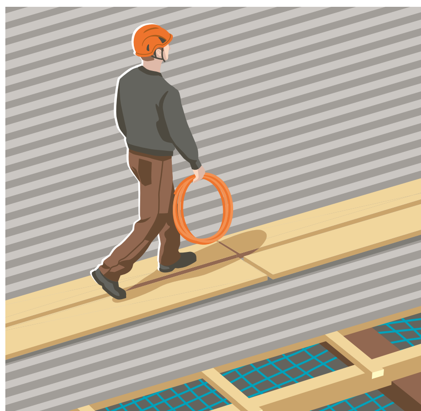
Regel 5: Wir arbeiten nur auf durchbruch sicheren Dachflächen.
