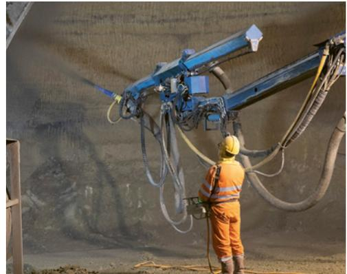
2 Wenn möglich Manipulator einsetzen, Aufenthalt im bereits gesicherten Bereich.
