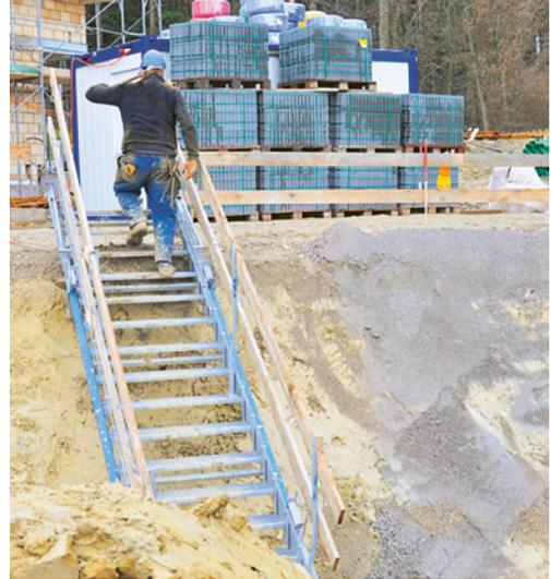
1 Sorgen Sie für einen sicheren Zugang in die Baugrube.
