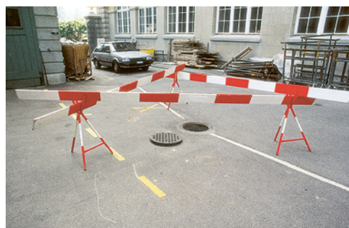
10 Absperrung eines Schachts
