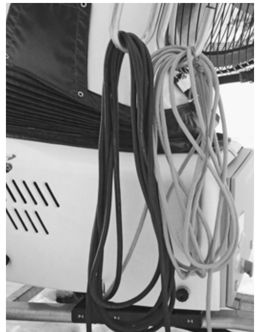
Bild 5: Nicht benötigte Kabel werden aufgewickelt.
