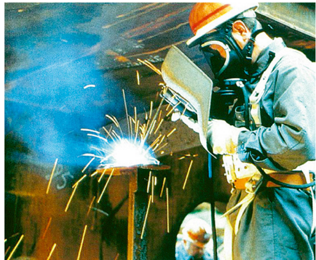
Bild 42 Schweißer mit einem von der Umgebungsluft unabhängigen Schlauchgerät für den Einsatz in engen Räumen, z.B. fensterlosen Kellerräumen
