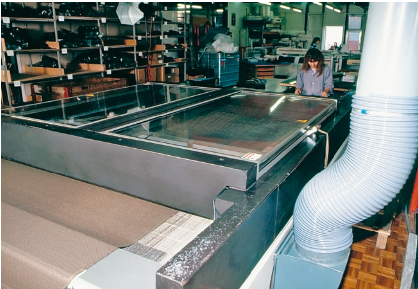
Bild 32 Kapselung und Absaugung bei einer Laserschneidanlage
