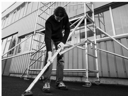
3 Dispositivo per evitare il ribaltamento del ponteggio mobile
