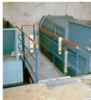
17 Die Wechsel-Lade-Kippmulde (WELAKI) ist beidseitig bequem und gefahrlos zugänglich. Das Ein- und Aushängen der Trossen wird damit erleichtert.
