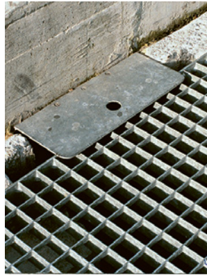
19 und 20 Die nicht benutzte Aussparung im Gitterrost lässt sich mit einer Klappe schliessen.
