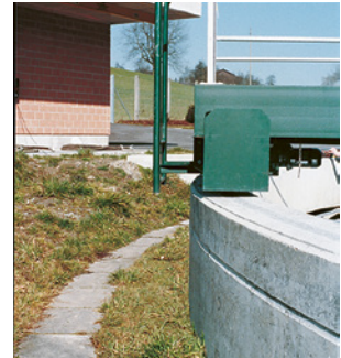
15 Durch Absenken des Terrains übernimmt die vorhandene Beckenmauer die Funktion der 110cm hohen Absturzsicherung.
