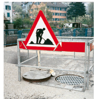
18 Mobile Abschränkungen zum Sichern von Bodenöffnungen sind immer vor dem Öffnen aufzustellen.
