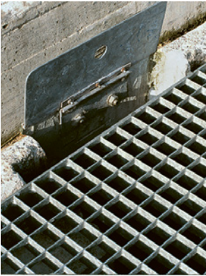
19 und 20 Die nicht benutzte Aussparung im Gitterrost lässt sich mit einer Klappe schliessen.
