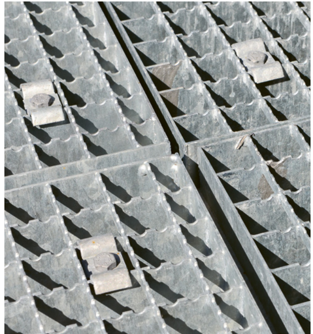
10 Jedes Element des Gitterrostes ist so befestigt, dass es sich nicht unbeabsichtigt verschieben lässt.
