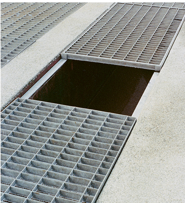
11 Seitliche Führung des Rostes. Sie verhindert, dass die Roste beim Verschieben in die Tiefe stürzen.
