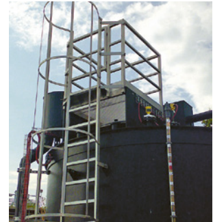
25 und 26 Leiteraufstieg mit Rückenschutz und Zwischenpodest. Der Leiterausstieg ist mit einer selbstschliessenden Geländertüre, die Dachkante mit einem Geländer gesichert.
