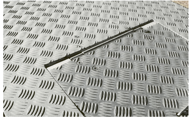
21 Versenkte Scharniere in Gehbereichen.
