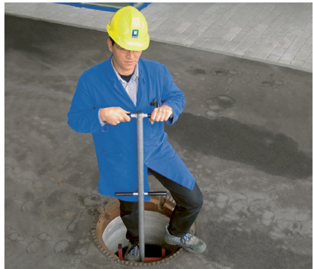
27 Einstieg in einen Schacht mit Hilfe einer Haltevorrichtung (Höhe mindestens 1 m).
