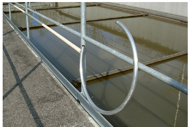
32 Rettungsstange, vorzugsweise unsinkbar, mit 3/4-Haken
