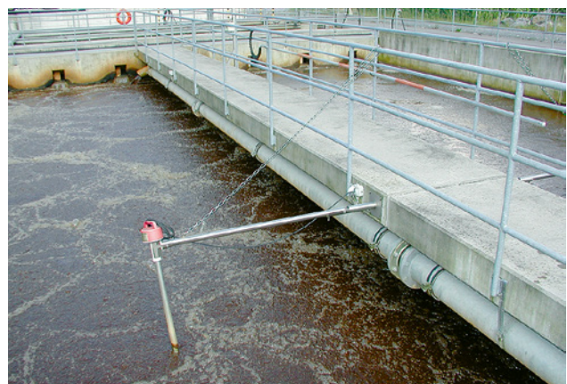
35 Die Messsonden des Belüftungsbeckens können zum Beispiel mit einer Kette zum Geländer am Beckenrand hochgezogen und so ohne Gefährdung kontrolliert und gereinigt werden.
