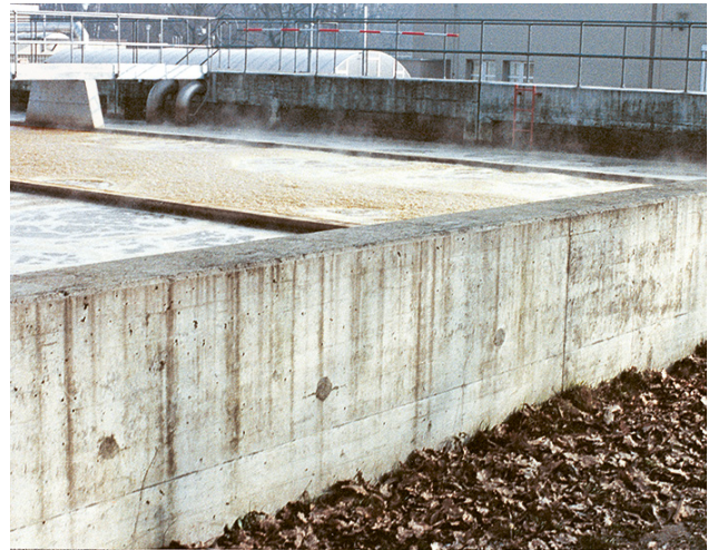
16 Beckenmauer, auf die Höhe von mind. 110cm über Terrain hochgezogen.
