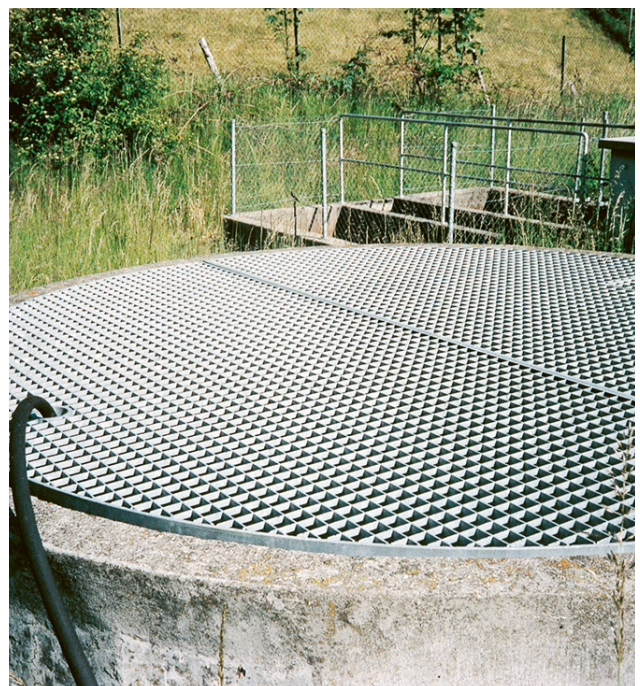
12 Roste und Abdeckungen müssen aus beständigen Materialien, z. B. Stahl oder Kunststoff, gefertigt sein.
