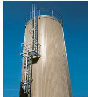
25 und 26 Leiteraufstieg mit Rückenschutz und Zwischenpodest. Der Leiterausstieg ist mit einer selbstschliessenden Geländertüre, die Dachkante mit einem Geländer gesichert.
