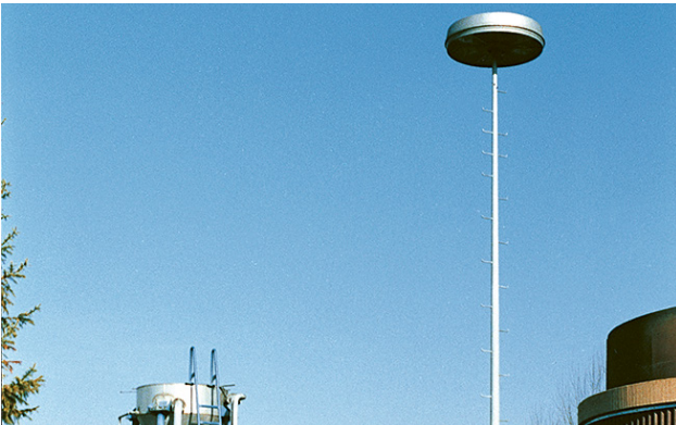
22 Eine gute Beleuchtung trägt dazu bei, dass notwendige Arbeiten, z. B. bei Störfällen, auch während der Nacht sicher ausgeführt werden können.
