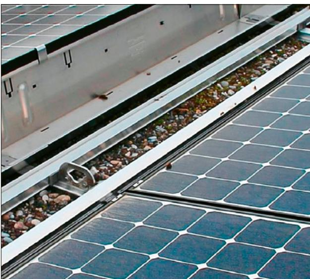
Anschlagpunkt an Photovoltaikanlage
