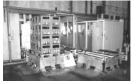
Figure 1: pour pouvoir contrôler régulièrement la présence et l'état des dispositifs de sécurité et des protections, il est impératif d'en avoir la liste complète.
