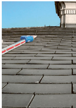
2 Dach mit asbesthaltigen Faserzementplatten
