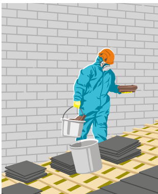
Regel 9 Vor Asbeststaub schützen.
