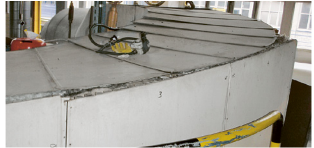
Isolamento posto dietro un rivestimento
