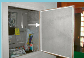
Isolamento in amianto spruzzato Pannello antincendio contenente amianto
