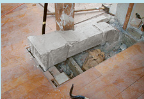
Canale di ventilazione in fibrocemento Impianto di ventilazione in fibrocemento
