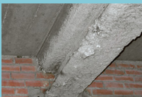
Isolamento in amianto spruzzato Pannello antincendio contenente amianto
