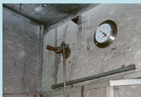
Canale di ventilazione in fibrocemento Impianto di ventilazione in fibrocemento
