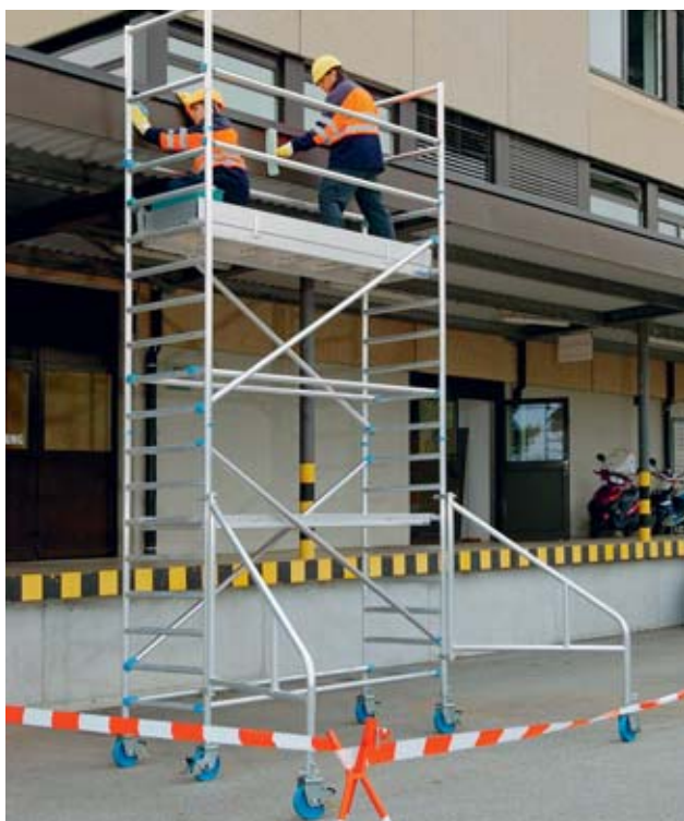
23 Pulizia di una facciata da un ponteggio su ruote.
