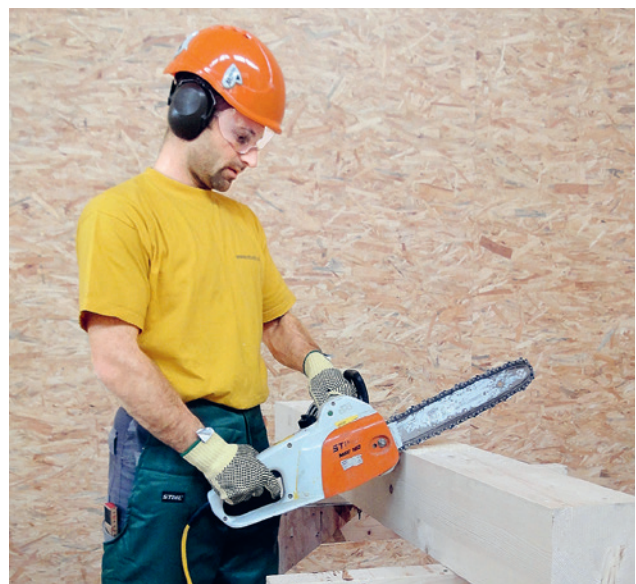
1 Équipements de protection requis
