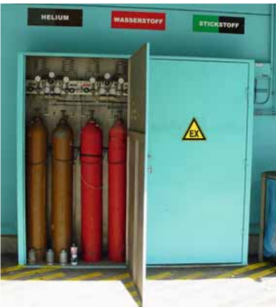
Fig. 4 Alimentation centrale en gaz
