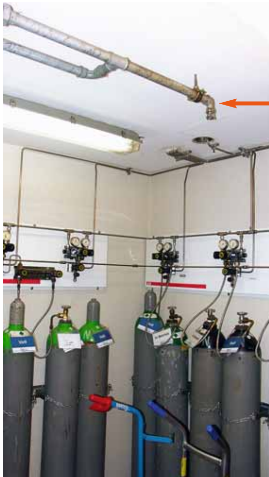
Fig. 8 Installation d'arrosage
