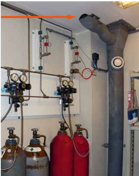
Fig. 19 Aspiration sous le plafond
