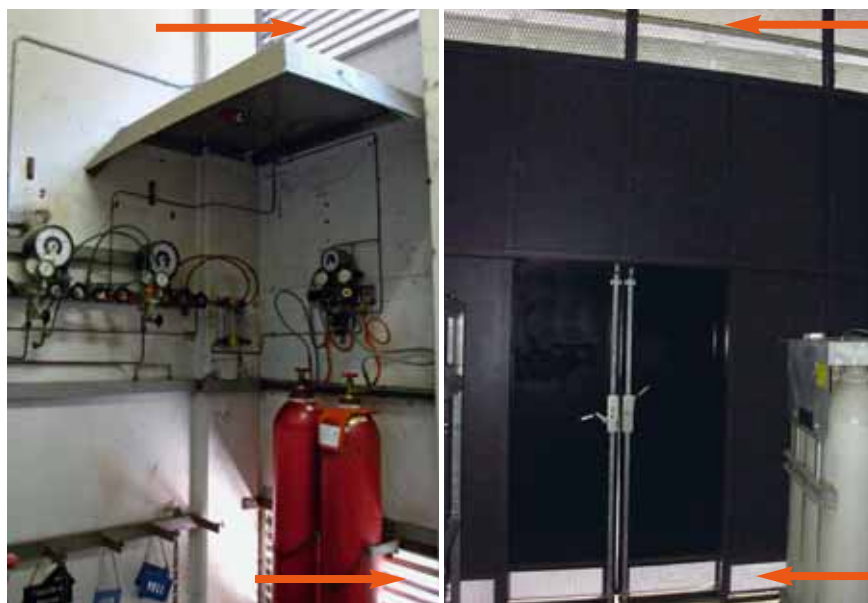
Fig. 18 Ouvertures pour la ventilation naturelle
