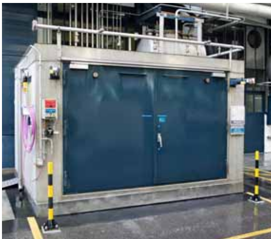
Fig. 6 Confinement pour gaz à potentiel de risque élevé
