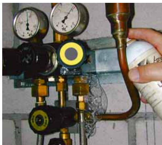
Fig. 26 Contrôle de l'étanchéité de l'installation
