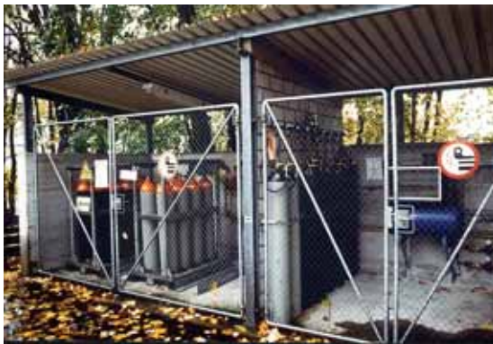
Fig. 20 Séparation effectuée avec un mur
