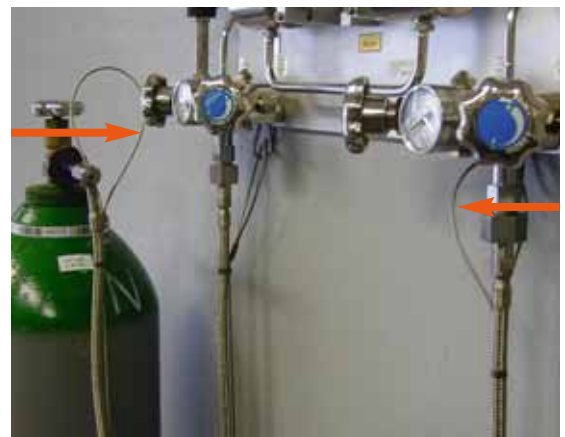
Fig. 12 Câbles de retenue
