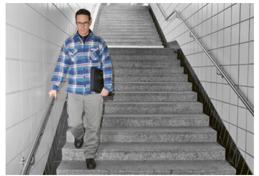
5 Escalier avec main courante de part et d'autre. Les contours de l'escalier sont bien visibles.
