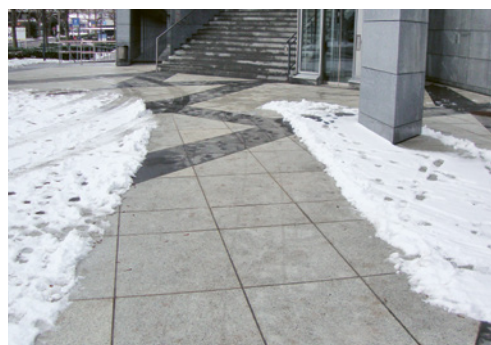
2 Voie de circulation dépourvue de neige et de glace.
