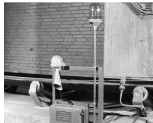
Figure 11: avertisseur de mise en marche. Selon la situation, on utilise des signaux acoustiques ou optiques, voire les deux, dans certains cas.
