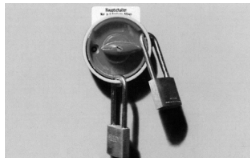
Figure 10: interrupteur de sécurité. Lors des travaux de maintenance, celui-ci doit être verrouillé avec un cadenas personnel afin d'éviter une mise en marche du transporteur par un tiers.
