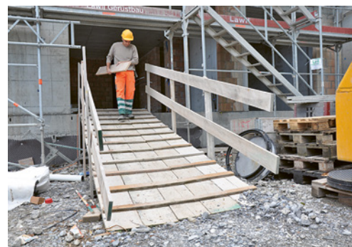
7 Accès de chantier sécurisé par une protection latérale et des lattes de retenue. Largeur minimale des accès de chantier: 1 m.
