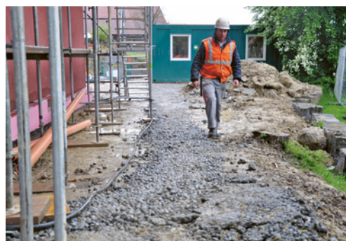
4 Voie de circulation temporaire sécurisée par une couche de béton maigre.
