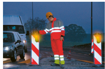
3 Wirksam beleuchtete Arbeitsstelle.
