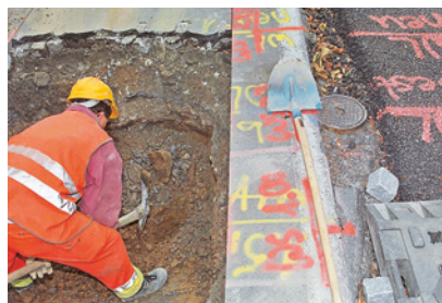
2 Werkleitungen bei Bedarf sondieren.
