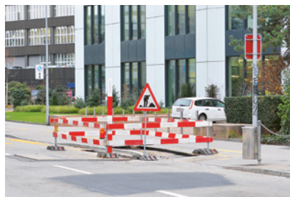
2 Auch bei kurz dauernden Arbeiten ausreichend signalisieren.
