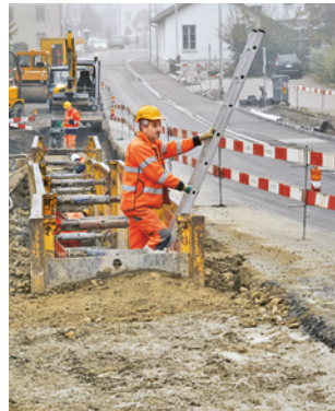
Regel 7 Sichere Zugänge erstellen.
