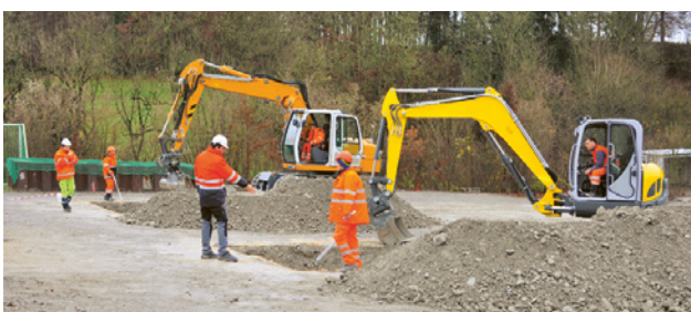
1 Ausbildung für das Bedienen von Baumaschinen.
