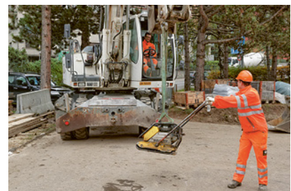
3 Korrektes Führen einer Last am Pneubagger.
