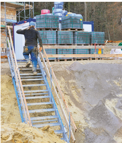
1 Zugang zu Baugrube mit Bautreppe.
