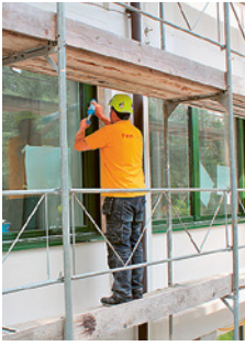
2 Ponteggio di facciata come protezione anticaduta
