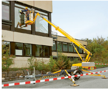
3 Piattaforme di lavoro elevabili in caso di facciate inaccessibili
