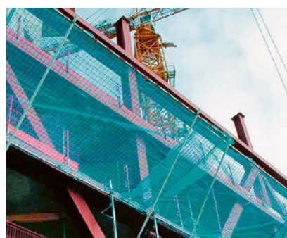
5-7 Questo tipo di reti di sicurezza viene impiegato raramente in Svizzera a causa dell'obbligo di montaggio del ponteggio di facciata (OLCostr, art.26).
