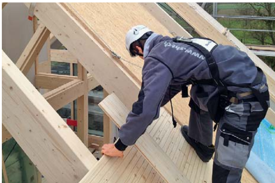
Il dispositivo anticaduta viene installato già nel padiglione di montaggio.
