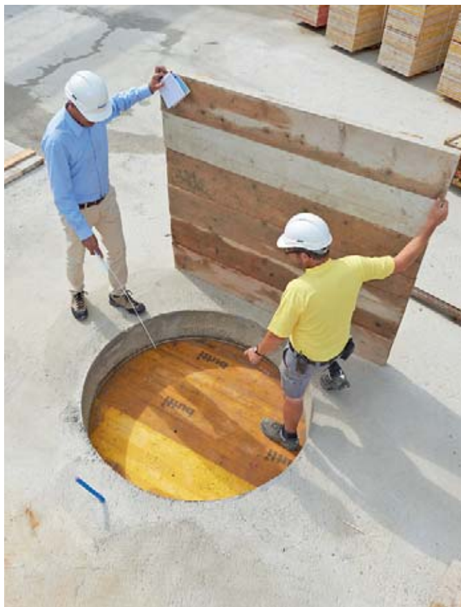
Audit regolari permettono di individuare i pericoli sul cantiere.
