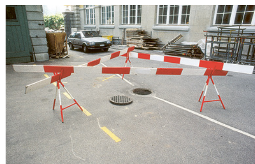
10 Sbarramento di un pozzetto
