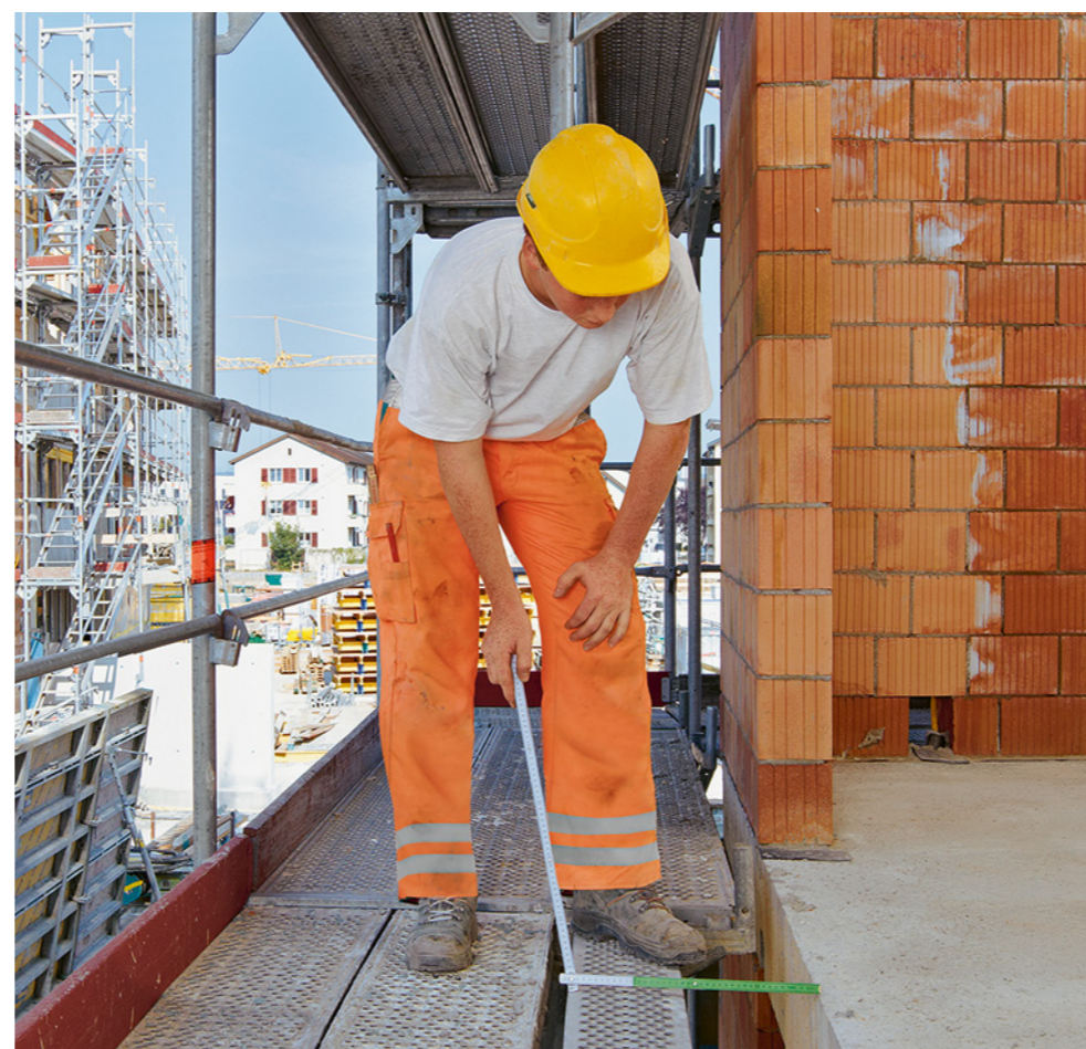
Regel 5: Wir kontrollieren die Gerüste täglich.
