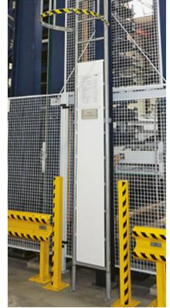
**2** Scala fissa a pioli con protezione dorsale e sistema di sbarramento di sicurezza per impedire l'accesso a persone non autorizzate.
