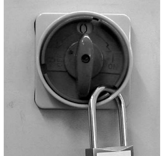
Bild 1: Sicherheitsschalter, der sich mit einem Vorhängeschloss sichern lässt.
