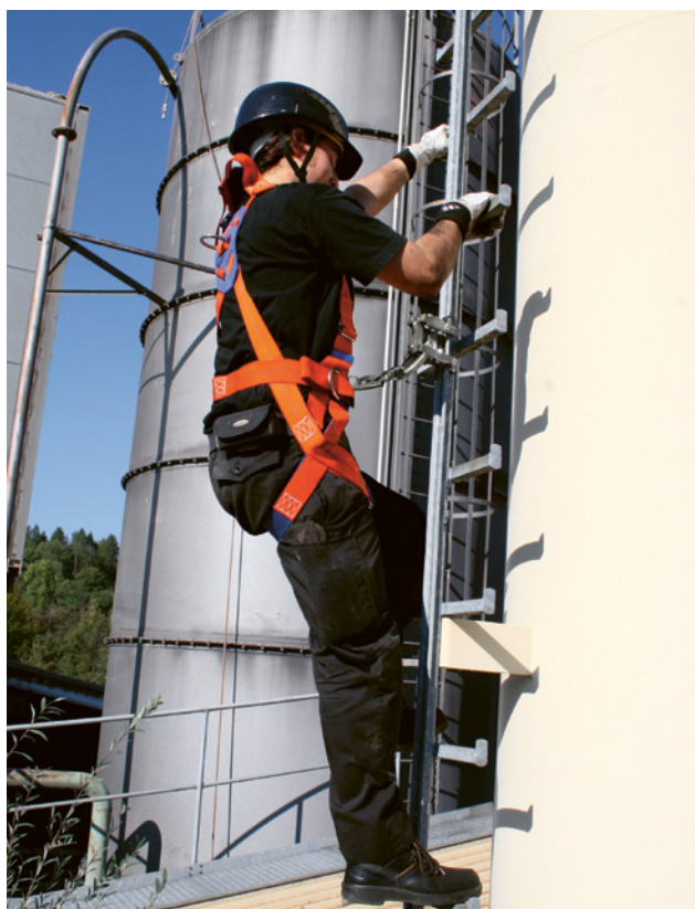
7 Protezione anticaduta con scala a pioli fissa e dispositivo anticaduta di tipo guidato su un camino di fabbrica
