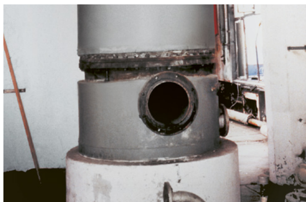
11 I materiali isolanti usati sulle caldaie spesso sono ricoperti da una lamina di metallo.
