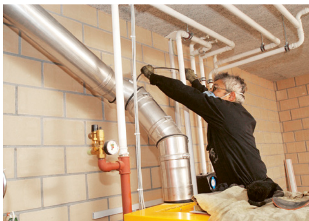
9 Uso professionale dei dispositivi di protezione individuale (guanti, maschera di protezione delle vie respiratorie e occhiali di protezione)
