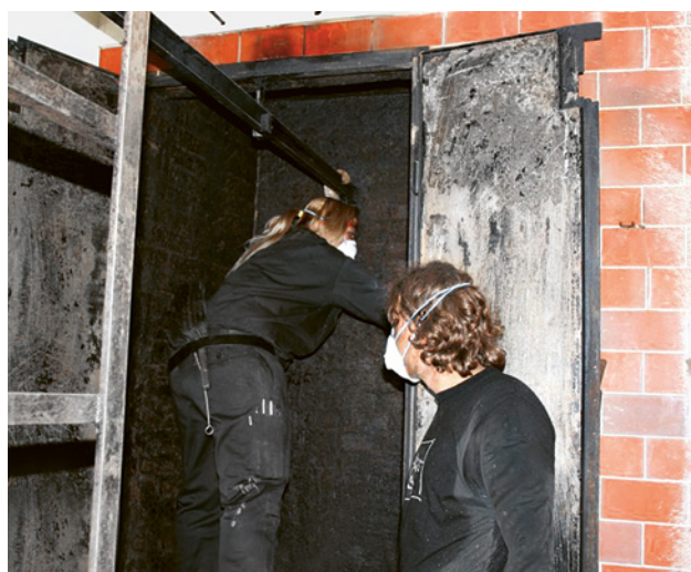
6 Mentre una persona si trova nella camera di combustione (camera a fumo), l'altra la sorveglia dall'esterno.
