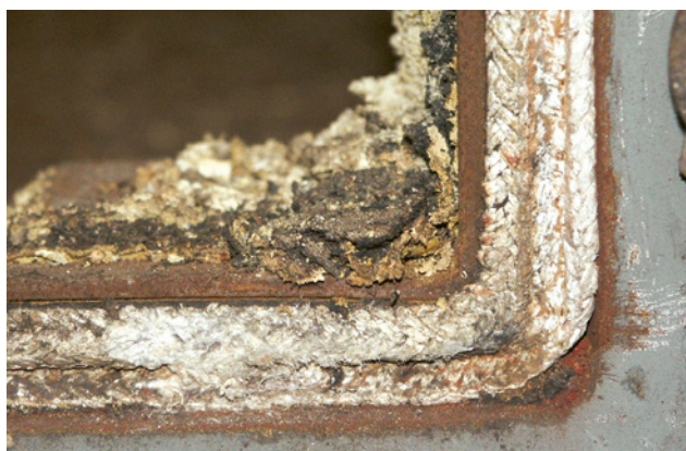
10 Attenzione alle stuoie di amianto isolanti e alle corde di amianto come guarnizione delle porte negli impianti a combustione!
