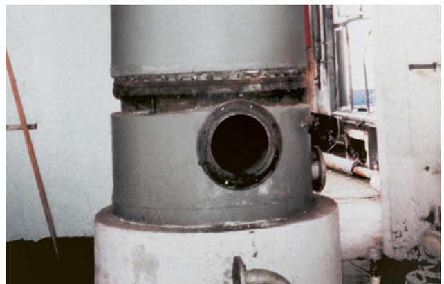
11 I materiali isolanti usati sulle caldaie spesso sono ricoperti da una lamina di metallo.
