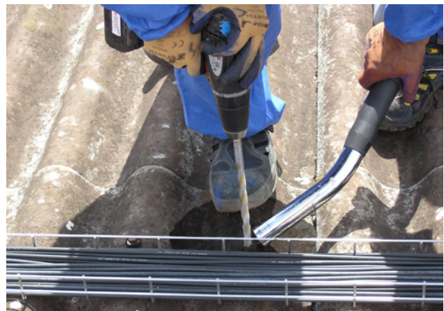
5 Inumidire il fibrocemento, praticare i fori a basso regime e aspirare alla fonte.
