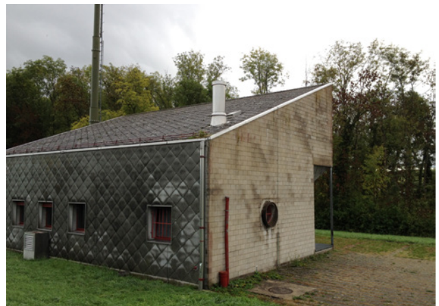
1 Nuovo camino su un tetto con copertura in fibrocemento
