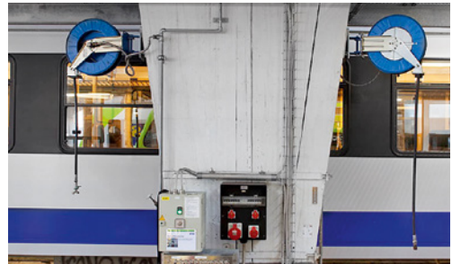
1 Ein Kabeldispenser schafft Ordnung und eliminiert Stolperfallen.
