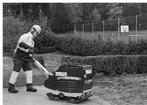
2 Porter les EPI nécessaires.
