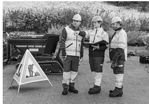
1 Planifier les travaux.
