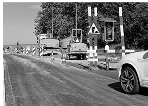
3 Signaler correctement le chantier sur la voie publique.
