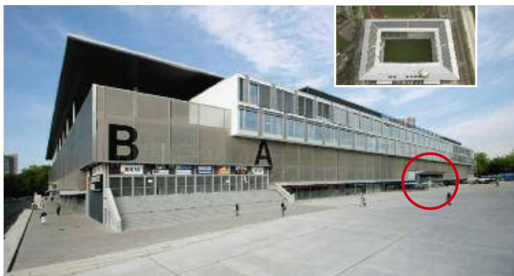
Illustration 1: Stade de Suisse à Berne et son centre commercial. Ce dernier occupe une partie du sous-sol du stade. Cercle rouge: entrée du centre commercial.
