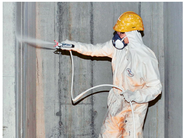
19 Beim Spritzen von lösemittelhaltigen Produkten sind immer Explosionsschutzmassnahmen zu treffen, und es ist immer eine Atemschutzmaske oder ein Atemschutzsystem zu tragen.
