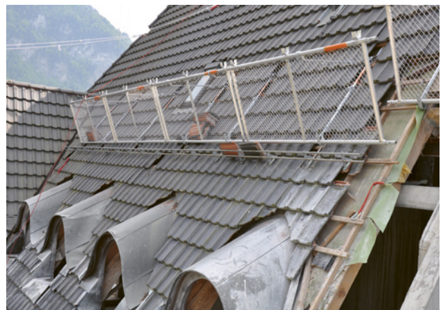
1 Korrekt erstellte Dachfangwand
