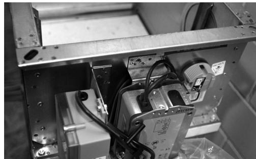
Les clapets coupe-feu doivent toujours être en état de fonctionner; les joints sales et les dispositifs de verrouillage corrodés altèrent leur fonctionnement.
