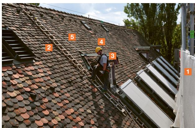
12 Arbeitsplatz-Positionierungssystem auf einem geneigten Dach
