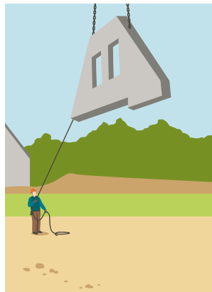
2 Last mit Führungsleine führen.
