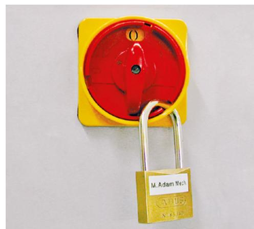
5 Interrupteur de sécurité pouvant être sécurisé par un cadenas personnel. Une étiquette précise, à l'emplacement de l'interrupteur, la partie de l'installation mise hors service.
